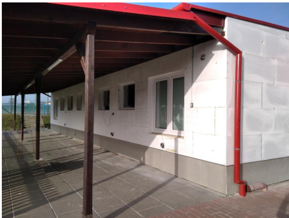
Dokončené zateplení kabin TJ Sokol
