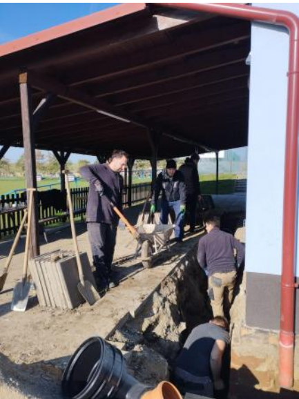
Brigáda - napojení kabin na ČOV
