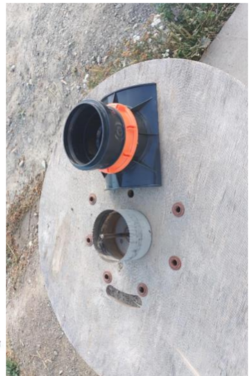
Obr. 2: Napojení odpadu mimo hrdlo
